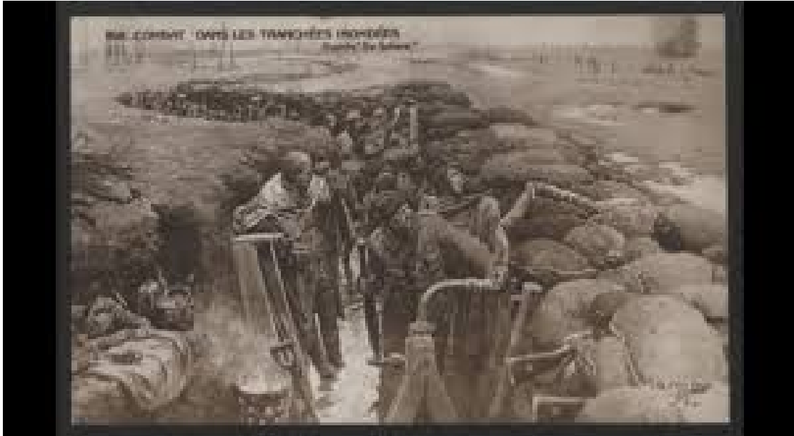
Dans les tranchées. centenaire.org
